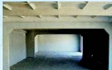
Sestava modulů B6 spojených otevřenou vnitřní stěnou - vnitřní pohled
